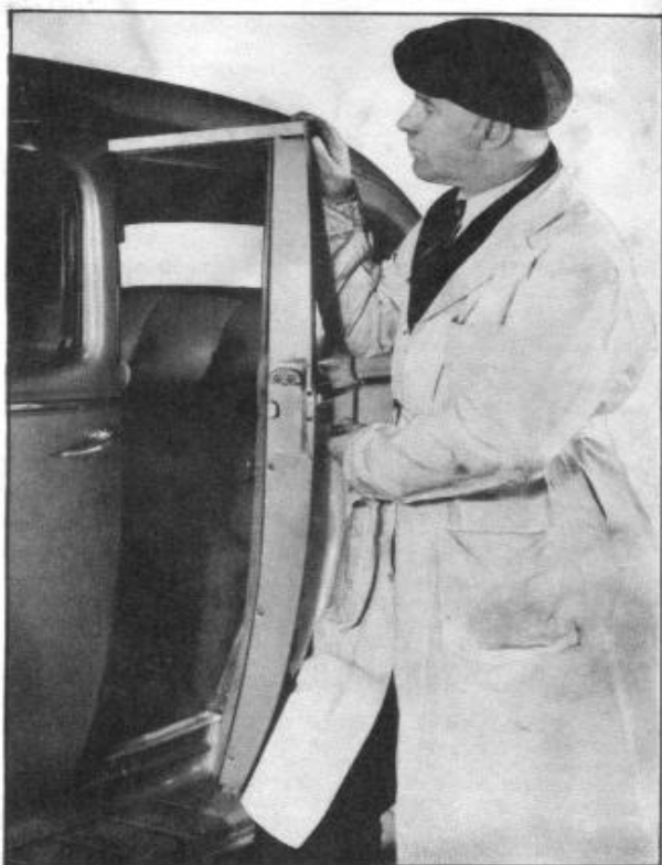
Figure 10--Aligning Door
